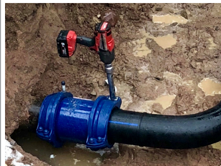
Ta ur det inre tätningslagret för större rör YD
